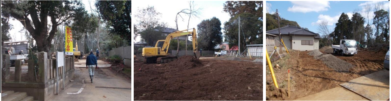
駐車場の整備
