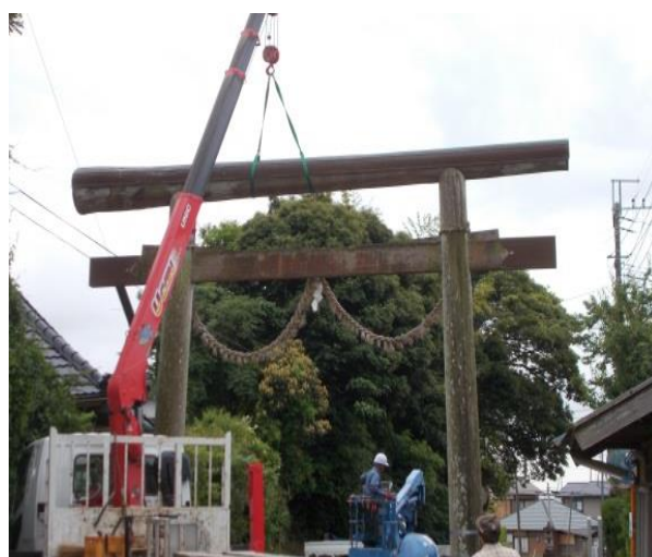
大鳥居の解体作業
