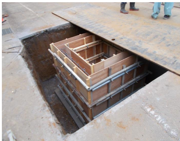
大鳥居基礎工事枠
