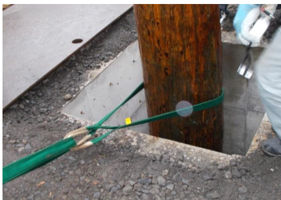
基礎枠へ大鳥居の取付
